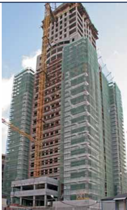
Леса «Профи» компании «Ринстрой», изготовленные методом пластической деформации. Строительство многофункционального комплекса. Москва, 2008г.
