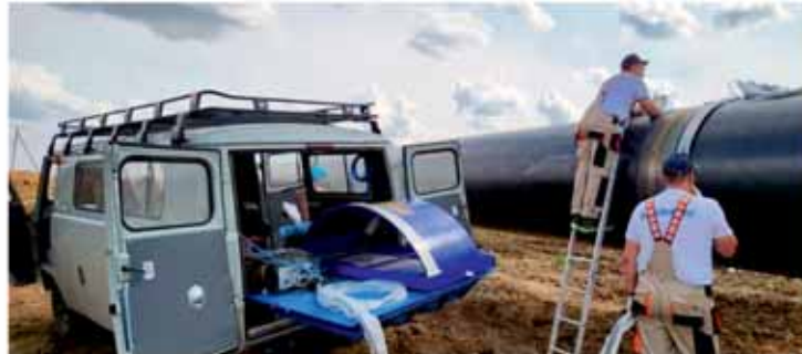
Испытания мобильной лаборатории на строящемся газопроводе
