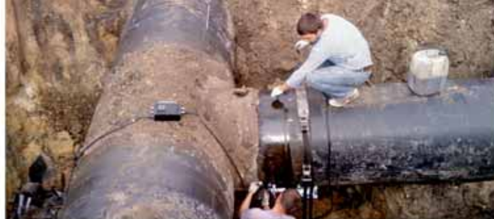
Контроль тройников сварных с накладками
