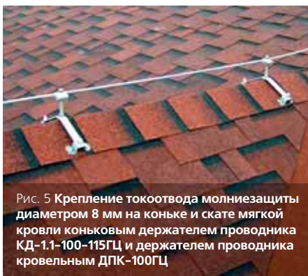
Рис.4 Крепление токоотвода молниезащиты диаметром 8 мм на коньке и скате мягкой кровли
