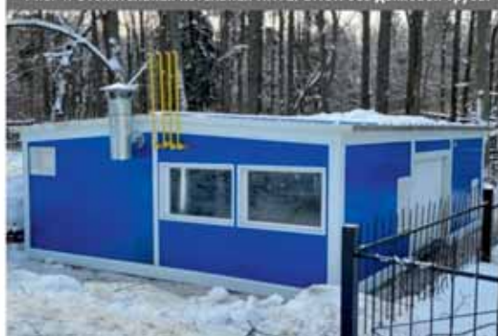
Рис.4. Отопительная котельная ИНТЕРБЛОК без дымовой трубы
