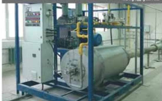
Рис.2. Промышленный парогенератор ИНТЕРБЛОК в контейнерном исполнении
