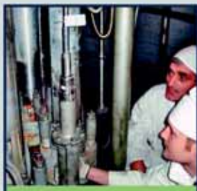
МОНТАЖ И АВТОРСКИЙ НАДЗОР
