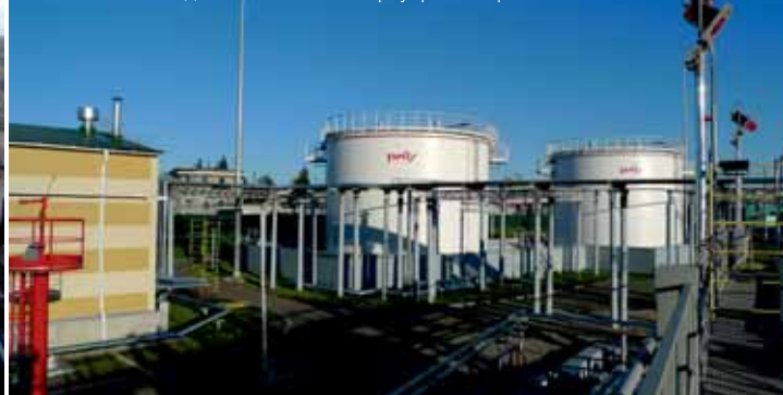
Топливный склад ст. Алтайская. Резервуарный парк
