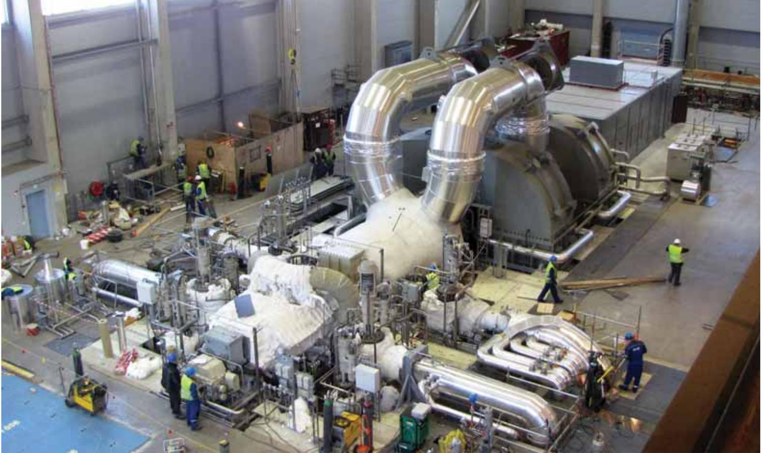
Монтаж паротурбинной установки, вспомогательного оборудования и трубопроводов проекта «Ювяскуле»
