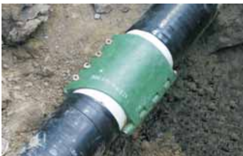
Рис. 5 Участок трубопровода, отремонтированный муфтой УКМТ
