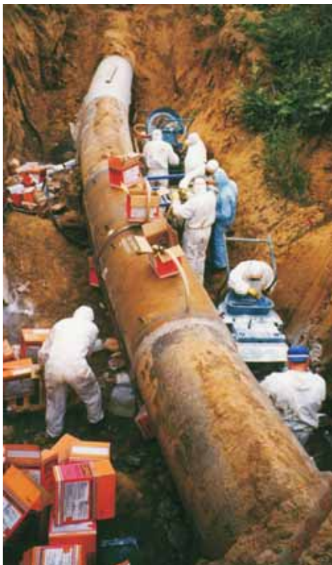
Рис. 1 Установка муфты КМТ
