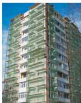
Хомутовые и рамные леса компании «Ринстрой» на объектах реставрации жилищного фонда г. Москвы.
