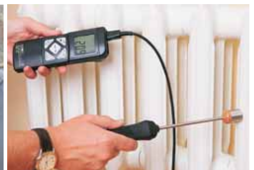
Контроль температуры поверхности радиатора в процессе пусконаладочных работ системы отопления
