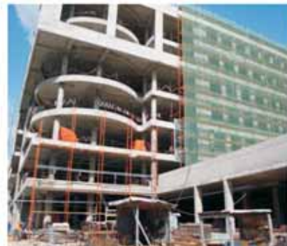
Леса «Профи» компании «Ринстрой». Строительство многофункционального комплекса на улице Сахарова, г. Москва.
