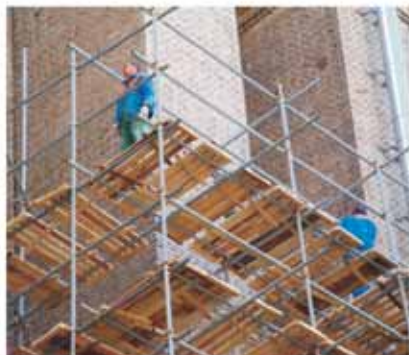
Хомутовые и рамные леса компании «Ринстрой» на объектах реставрации жилищного фонда г. Москвы.
