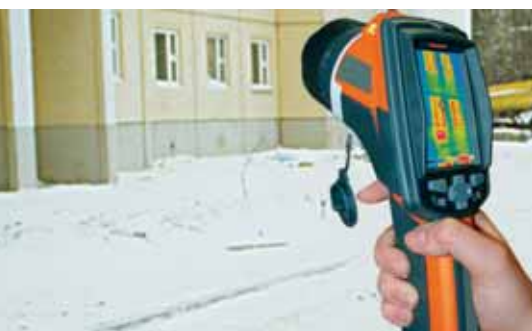
Контроль состояния межпанельных швов, поиск утечек тепла через ограждающие конструкции
